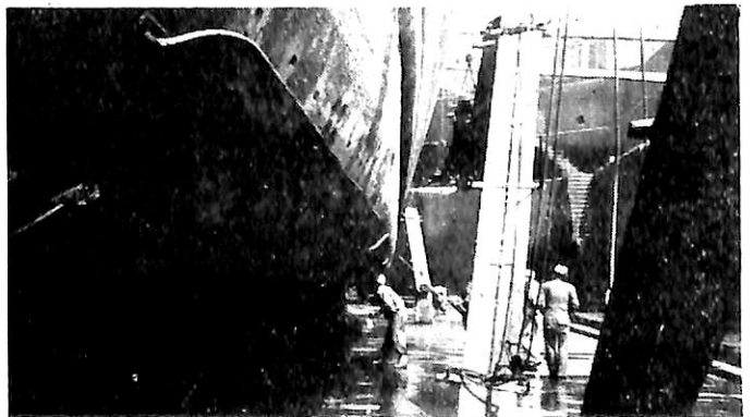
写真6 上方にまくれあがつたビルジキール
