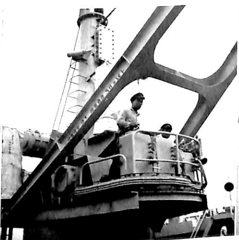
旋回式ジブクレーンの操縦台
