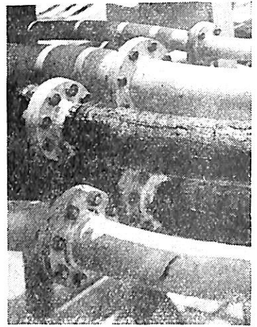
船舶の配管ジョイントに使用している例
