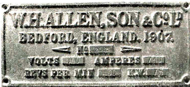
天洋丸、地洋丸両船に使用された発電機のネームプレート (出力75KW 当時本邦最大の船用発電機)
