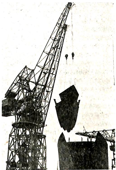
船首部ブロック取付中
