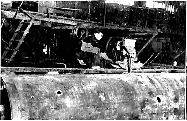
第8-9図 ドラムの自動熔接
