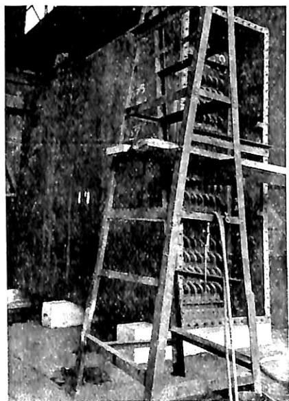
第8—35図 節炭器組立状況
