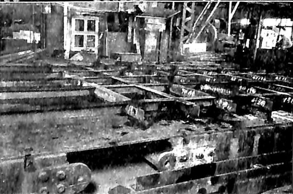
第8-25図 底面囲の加工
