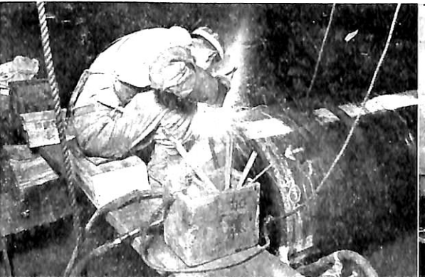
第8-12図 ドラム円周接手熔接
