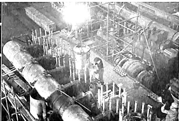
第7-8図 ピストン挿入
