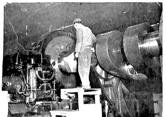
オ5-14図 クランクピン旋盤の作業状況
