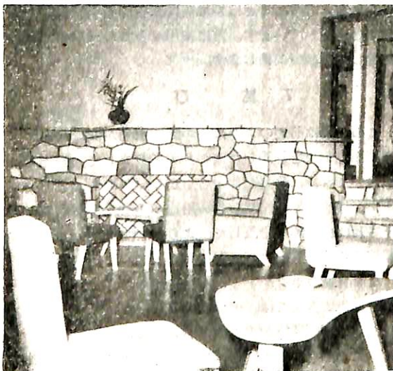
長岡ホテルサロン壁 (ホモゲンホルツ、クリヤーラッカー仕上げ)
