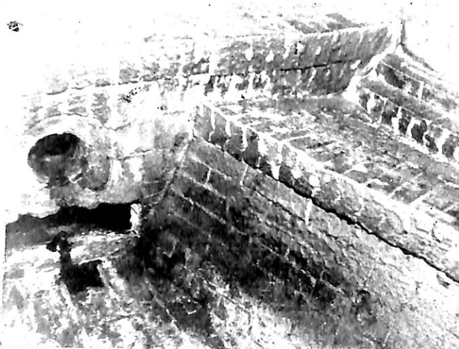
第8図 上の図は汽車のボイラーでの普通の高温セメントを用いて築いた燃焼室の図で甚しいスパーリングを起しスラッグが出来ている4カ月後の状態を示したものの。
