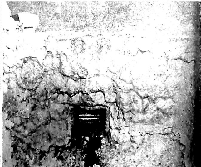
第8図 上の図は汽車のボイラーでの普通の高温セメントを用いて築いた燃焼室の図で甚しいスパーリングを起しスラッグが出来ている4カ月後の状態を示したものの。
