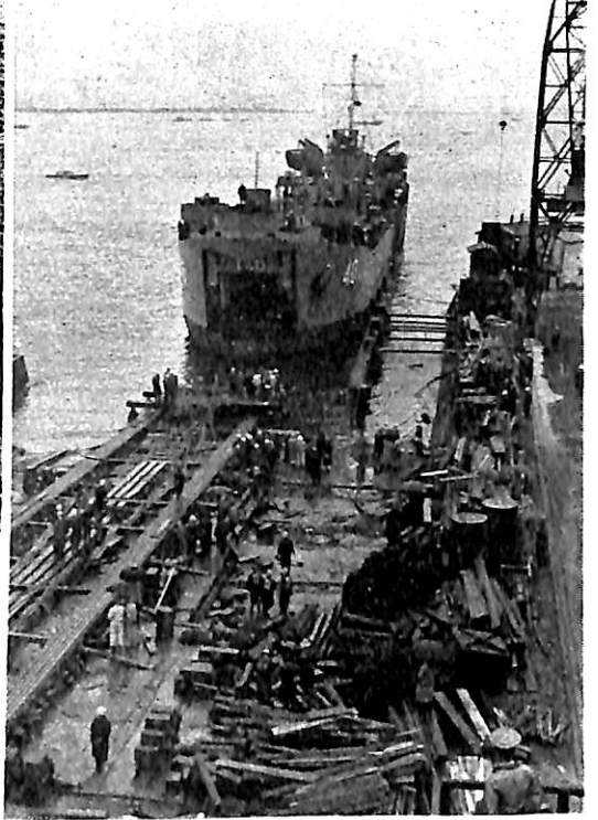
写真2 船体中心と船台中心を合せて巻揚準備にかゝる
