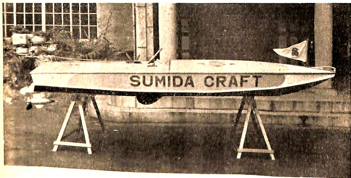
完成した艇体の外観 船尾に装備してあるのはキヌタ B 級モーター 船側の文字及び甲板のマークは塗装せず生地のまま
