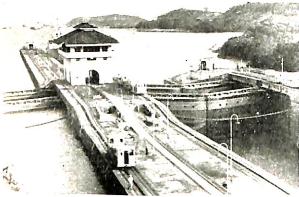
第23圖 Pedro Miguel 閘門から Miraflores湖 を距てて Miraflores閘門及びバルボア 高地地帯を遠望する。
