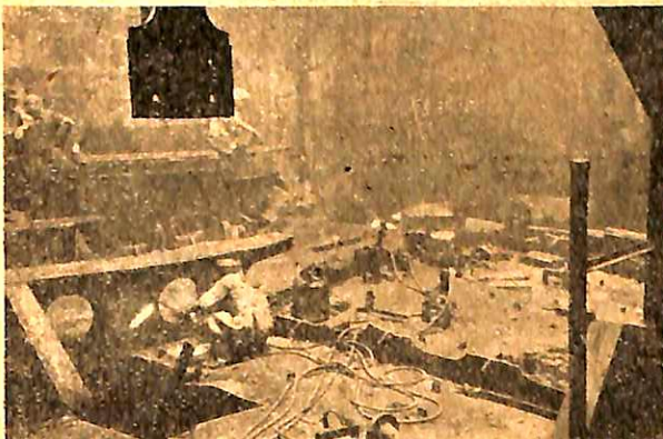
船内取外工事
