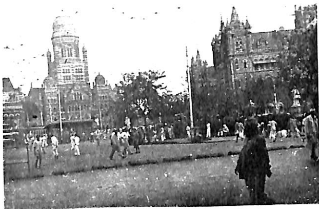
(G)ボンベイの市街 正面は市役所、右手はヴィクトリア停車場
