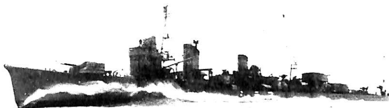
輕巡洋艦 能代 (第133號艦) 昭和18年6月運轉公試中の姿。水雷戦隊旗艦用。最も嶄新な設計。大和、翔鶴同様 Bulbous Bow である。外舷全周に磁気機雷除けの外舷電路 (Degaussing Coil) がまいてあるのがよく分る。主砲15種連装砲は本艦級のみ採用されている。同型艦 阿賀野(第132號艦) 矢矧(第134號艦) 酒匂(第135號艦)
