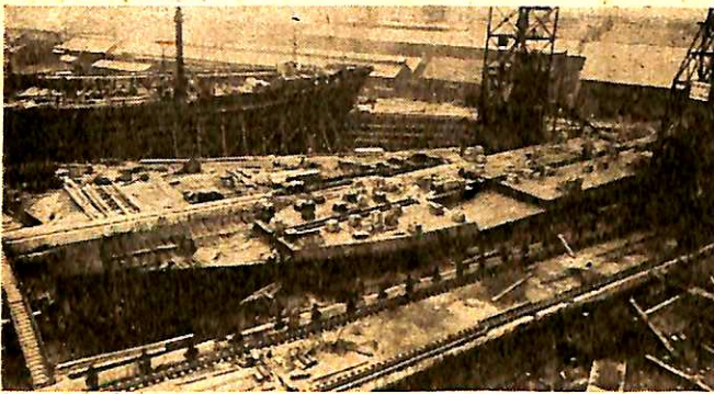
③ 二重底取付完了
