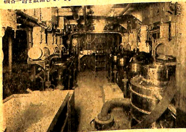
写真説明 左 製油工場の一部（肝油製造工場） 右上 // （後部をみる）右側ハートマンボイラー 右下 // // 右手前クワナーボイラー
