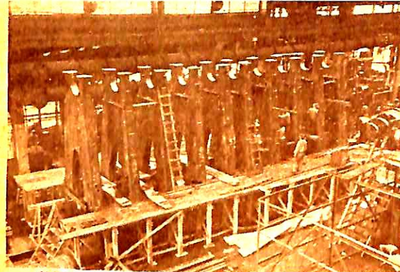
第7圖 臺板上に全支柱を立て揃え位置を決定する
