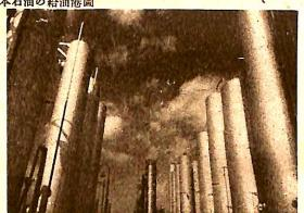
柏崎製油所 中央精密蒸溜裝置 兩端連絡洗滌裝置
