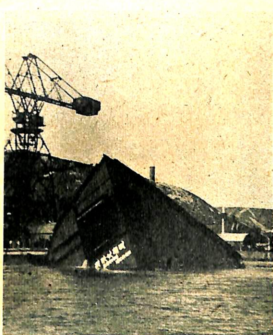
⑦ 転倒後の安定状態
