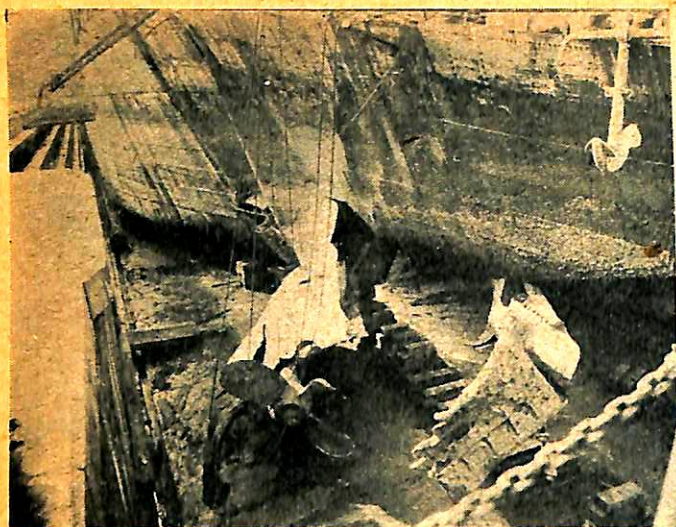
① 船尾部損傷状況
