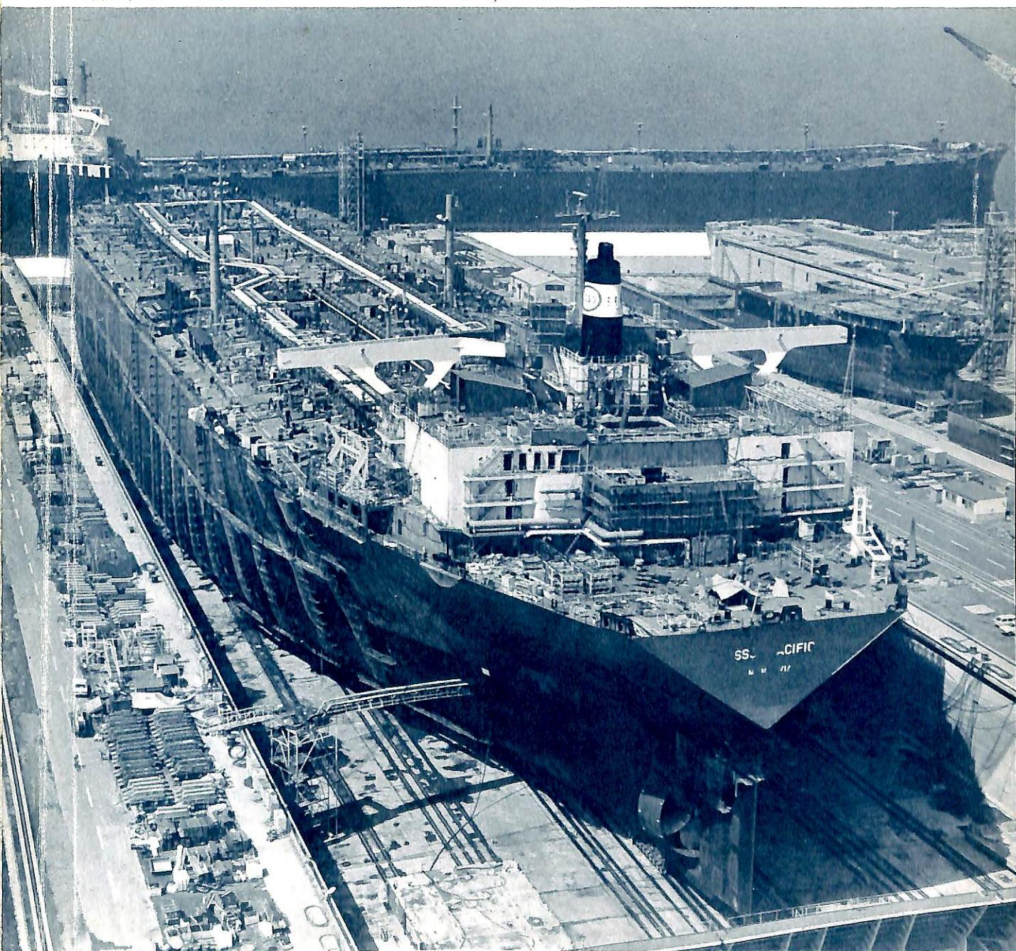
Esso Tankers 向け 50万 DWT 油槽船
