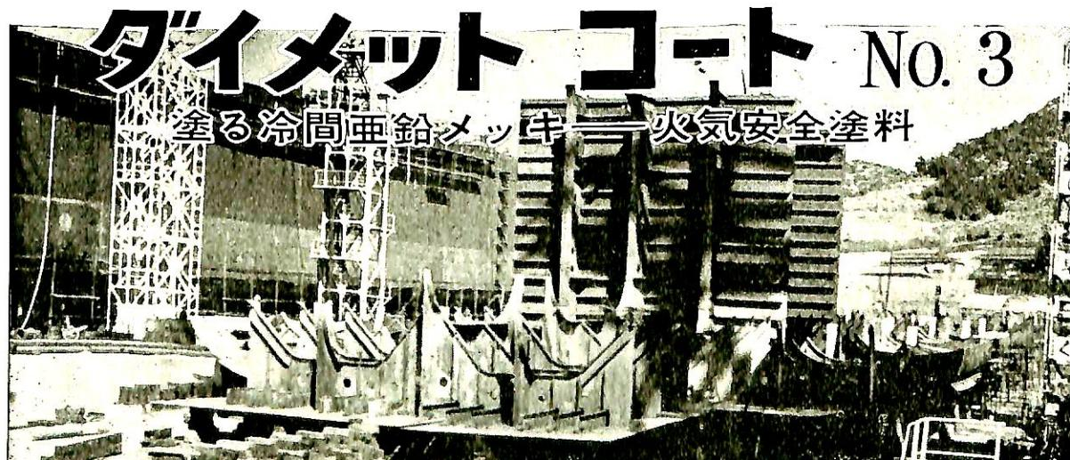
100% 無機物の珪酸亜鉛塗料, 従来の亜鉛メッキの常識を覆す画期的防錆用塗料です。タンク内の塗装でも引火の危険の全くない不燃性安全塗料です。米国アマコート会社製品。
